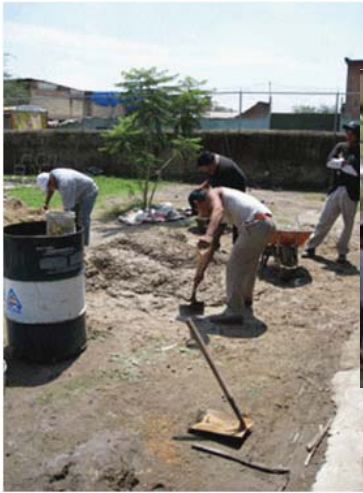
Beton mischen und Bodenplatte betonieren
