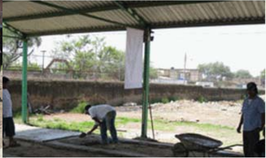
Beton mischen und Bodenplatte betonieren
